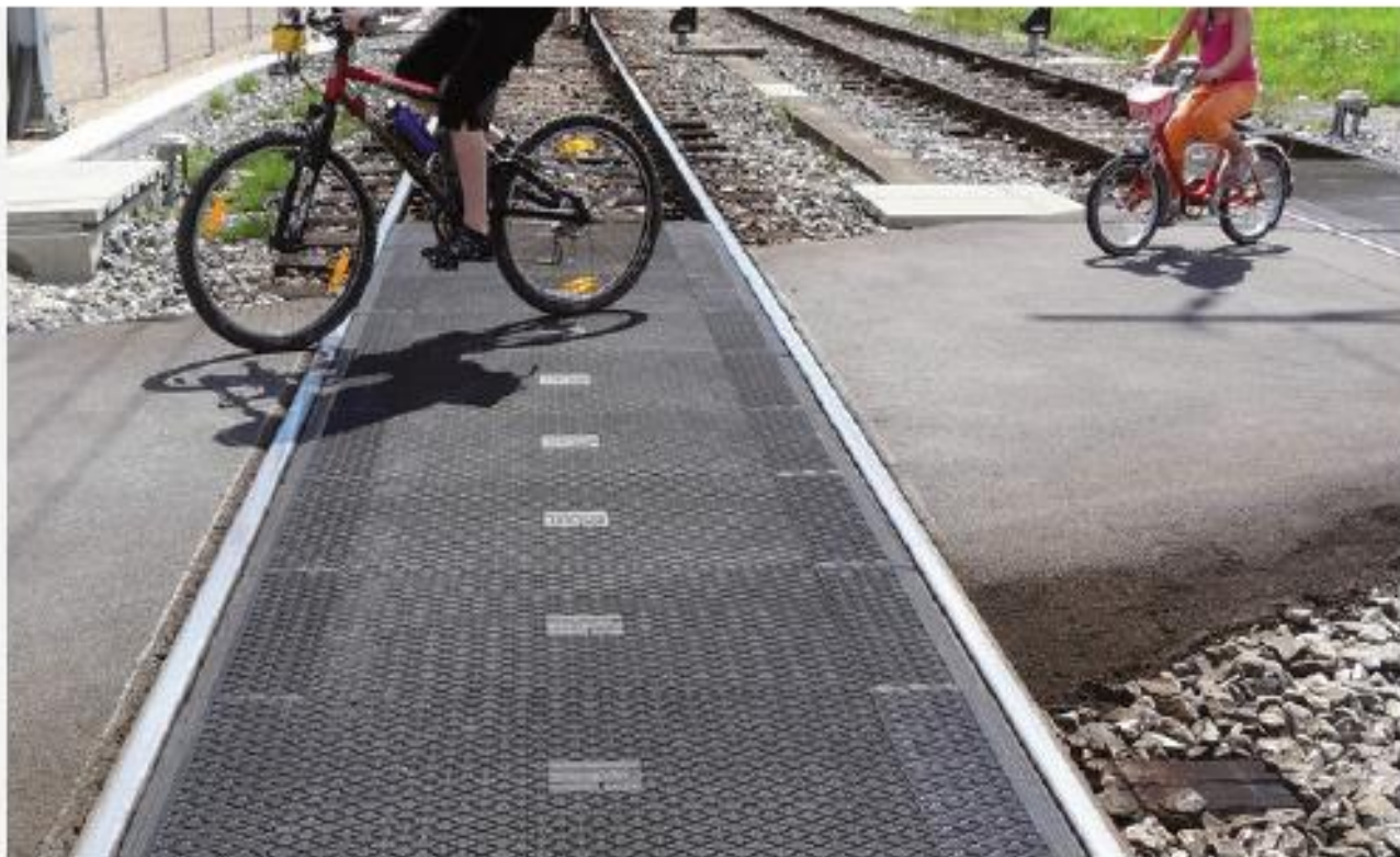
ZDJĘCIE 42. Bezrowkowy przejazd rowerowy przez linię kolejową:
