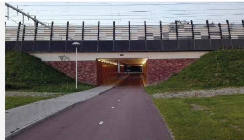
ZDJĘCIE 41. Holandia, Amsterdam, bezkolizyjne skrzyżowanie drogi dla rowerów z linią kolejową.
